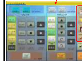
リビングの住宅設備操作画面
